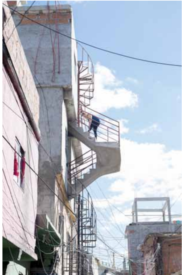
— Wendeltreppe im Barrio Güemes (2015)
