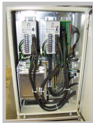
Abbildung 47 : Antriebsschaltschrank
